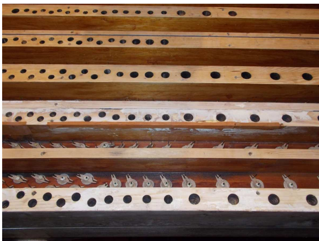
Obr. č. 43: Registrové kancely po vyčistení a oprave deštruovaných častí.
