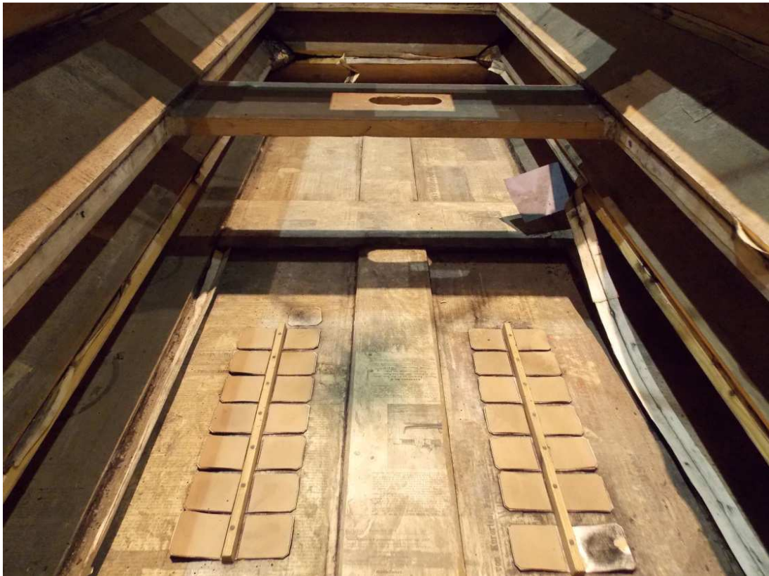
Obr. č. 28: Vnútro zásobného mechu počas demontáže.
