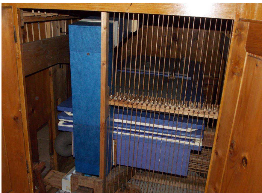
Obr. 13: Sústava mechov so zvislým vzduchovodom – stav po reštaurovaní.
