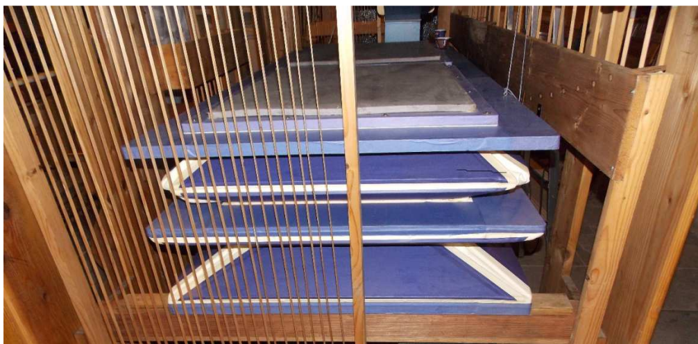
Obr. 14: Dvojfaldový zásobný mech francúzskeho typu. Popred mech prechádzajú abstrakty C strany tónovej manuálovej traktúry, napravo vidieť hriadeľovú dosku pedálovej traktúry - stav po reštaurovaní.
